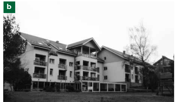
4 pav. a) Poilsio namų „Rūta“ I rekonstrukcija (Google Street View, 2013); b) buv. poilsio namų „Rūta“ I korpuso rekonstrukcija, dabar – viešbutis „Nidus“ (G. D. Kuverto g. 15, Nida) (nuotr. autorės).
